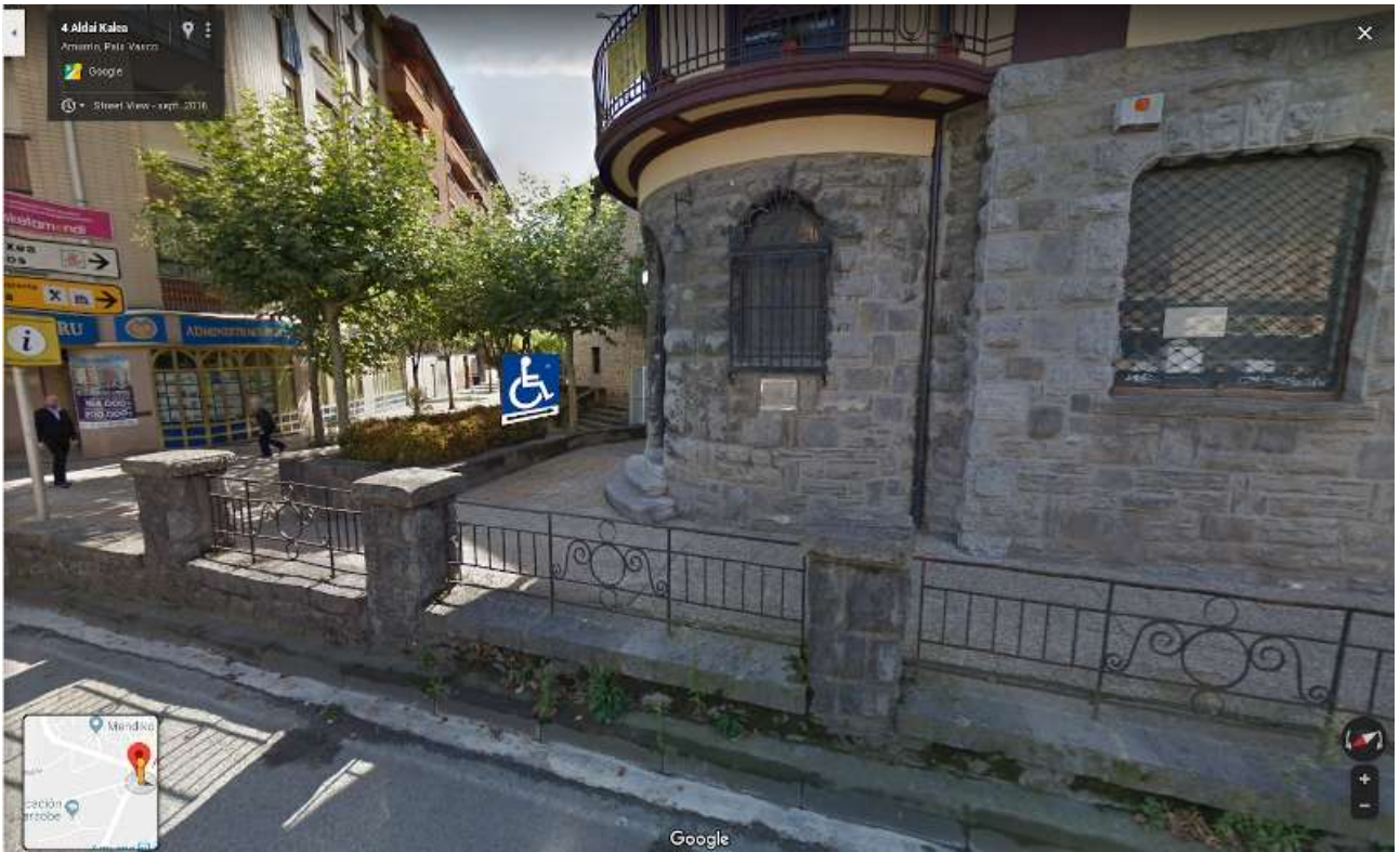
Irudia 19: Muro de protección de la acera perimetral
